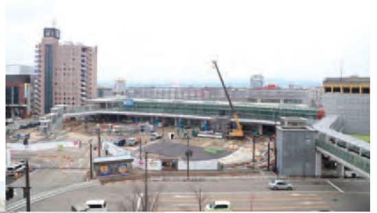
工事が進む高岡駅周辺整備事業 駅前広場、新高岡駅「curun TAKAOKA(クルン高岡)」 人工デッキを一体的に整備し、 今年3月の完成を目指します。
