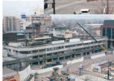
建物の解体が進む東側地区の駅前ビル
