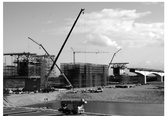
北陸新幹線の建設現場(庄川橋梁)
