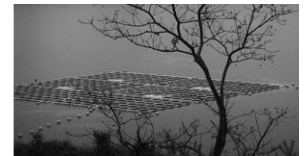
尾張東部浄水場
